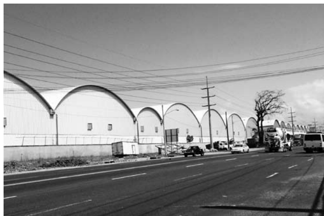
立ち並ぶコロン・フリーゾーンの倉庫群 (撮影: 筆者)
