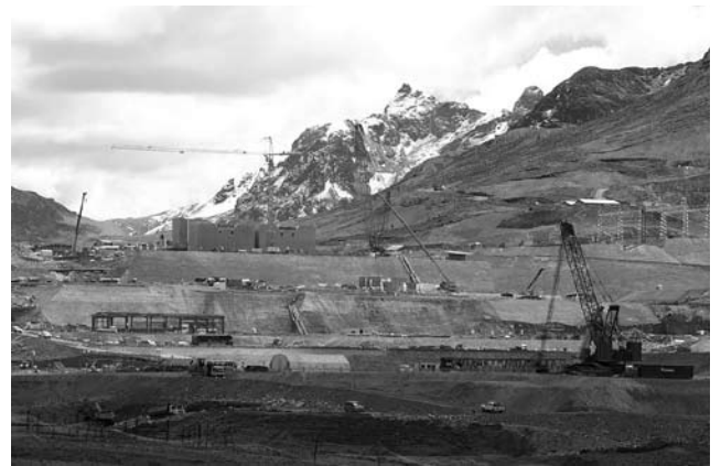
建設中のトロモチヨ鉱山選鉱所（撮影：2012 年 6 月 五味 篤）
