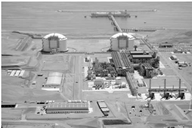
ペルー LNG プラント 提供：ペルー LNG
