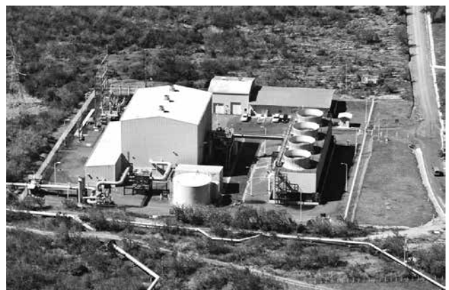
Miravalles 発電所 3号機
